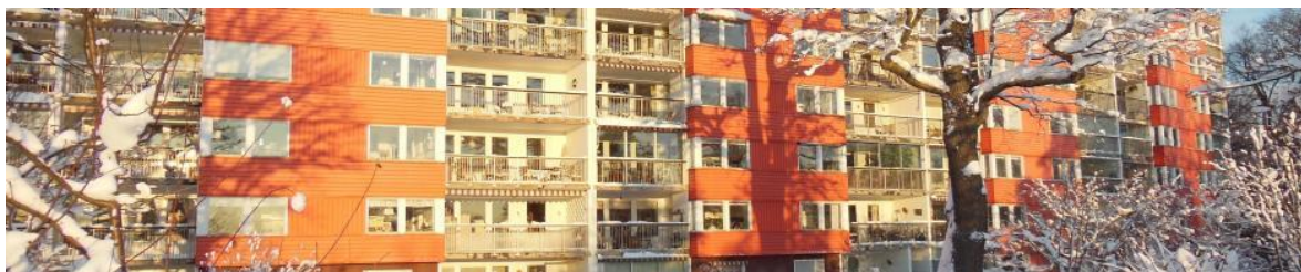
Figur 7. Fasad mot Värtan (BRF Ekbacken nr 1,2017a)
