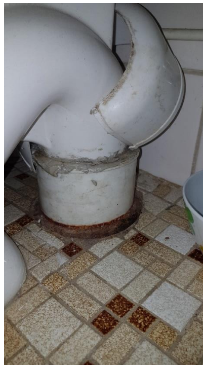
Avsättning i bjälklag av gjutjärn
